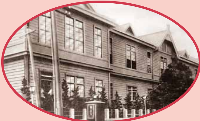
明治43年竣工の木造2階建校舎
